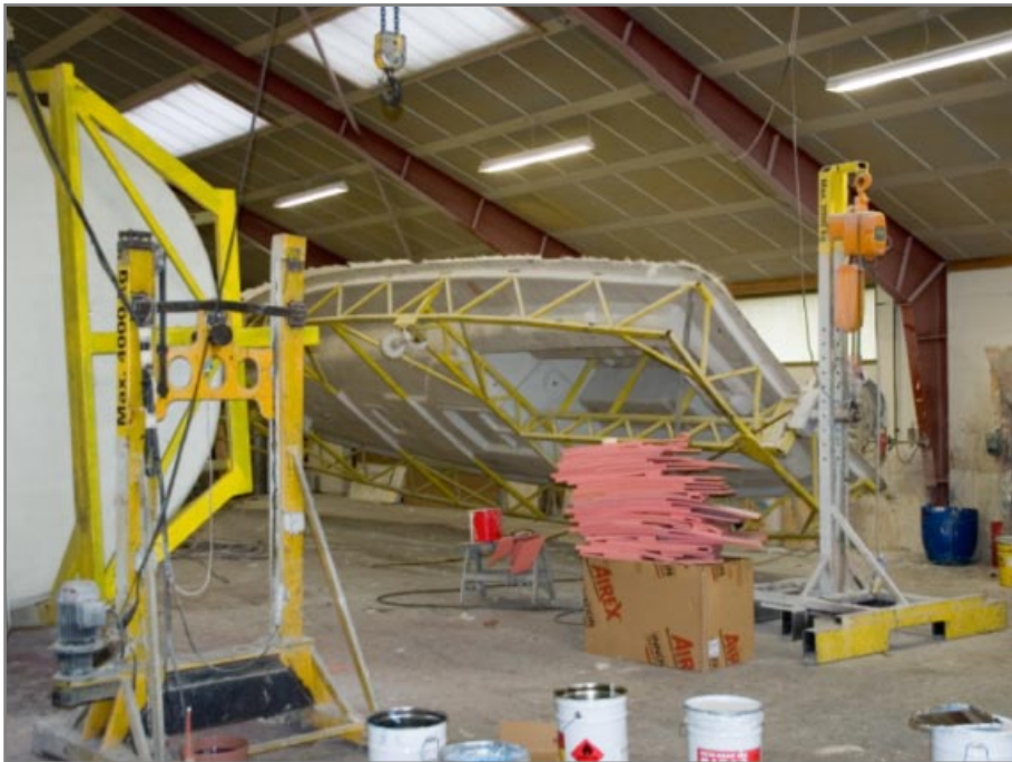
Støbeform til dæk - set bagfra
