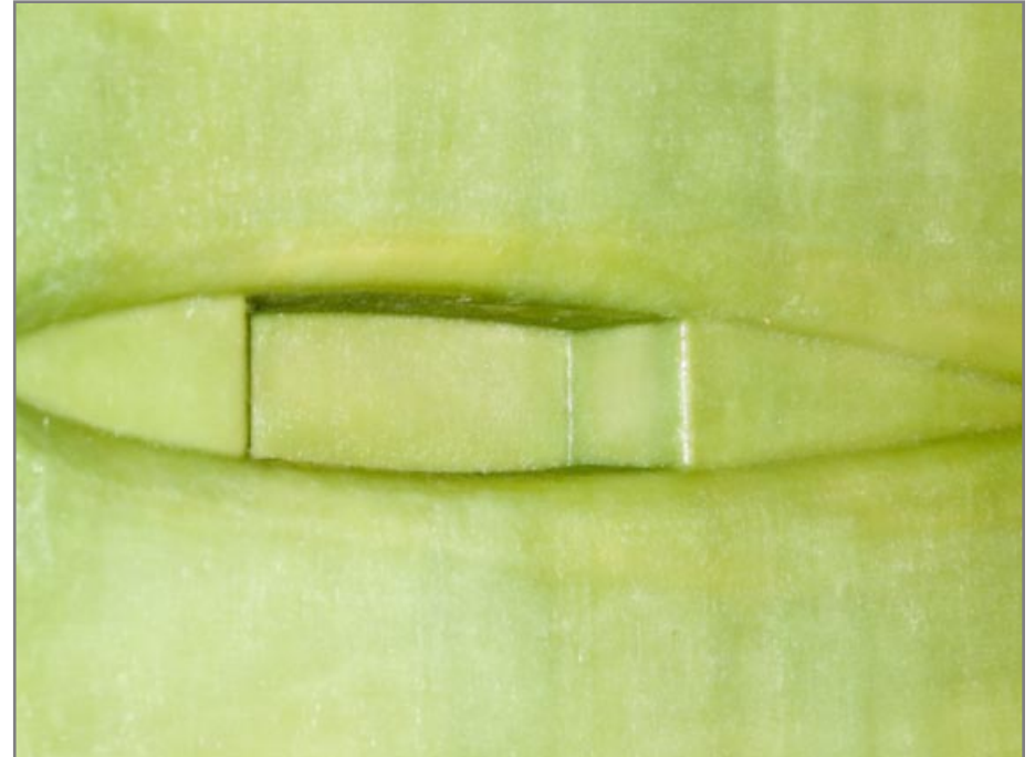
Fæste for bundramme - dette er opsamlingssted for evt. vand
