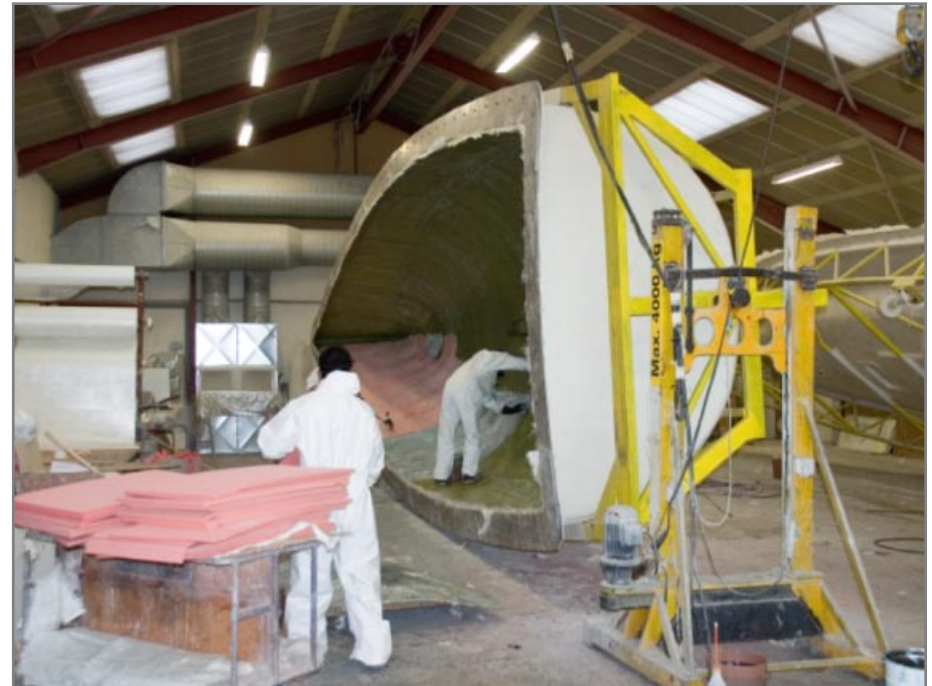
Indstøbning af Divinycell mellem glasfiberlagene. Støbning af skrog Faurby 396 - Avalon - Byggenummer 11
